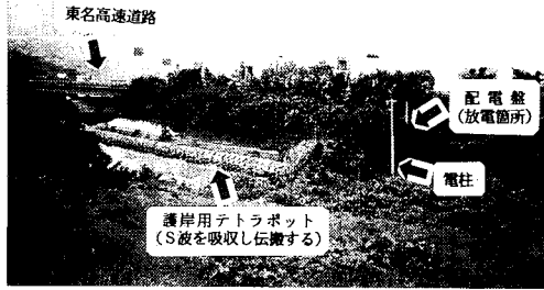
④地点より矢印方面 東名浜名湖橋と電柱を含む全景
