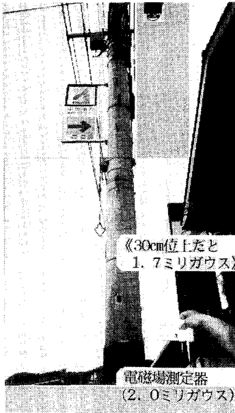
電柱の真下で測定
