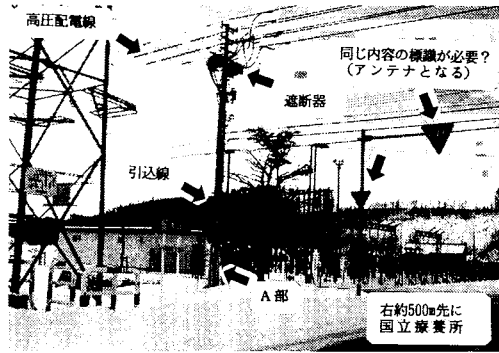
高圧配電線 遮断器 引込線 同じ内容の標識が必要？ (アンテナとなる)
