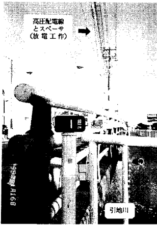
高圧配電線とスパーサ (放電工作)
